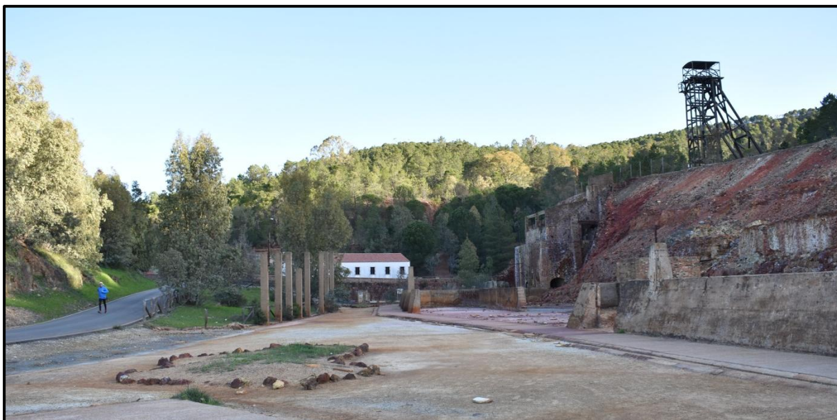
Vista de parte del conjunto minero.
