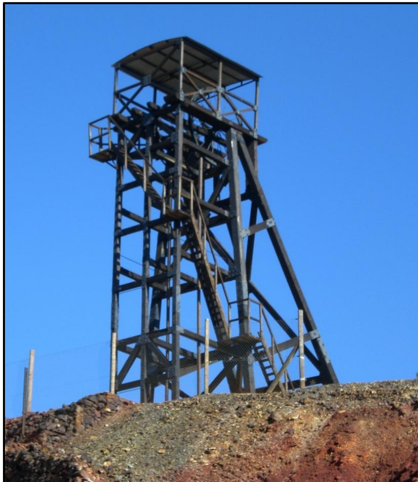
Estructura metálica de la reconstrucción del castillete del Pozo Maestro.
