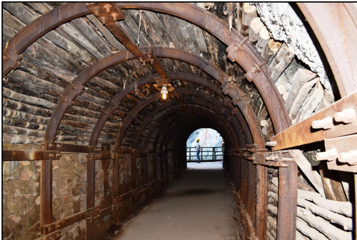
Entibación con cuadros metálicos y relleno de madera en un tramo del túnel Werner.
