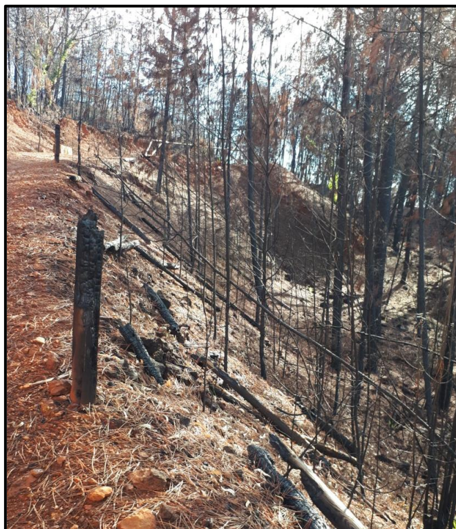
Vallado de seguridad quemado tras el incendio de agosto de 2018.
