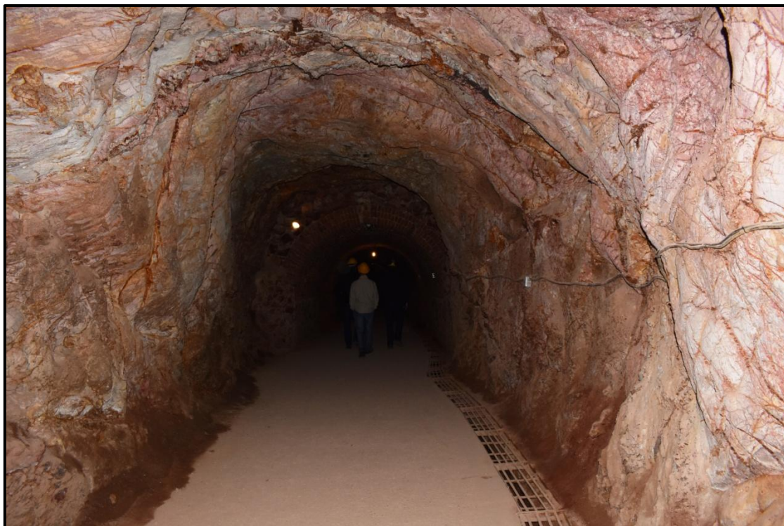
Sostenimiento natural en un tramo del túnel Werner.
