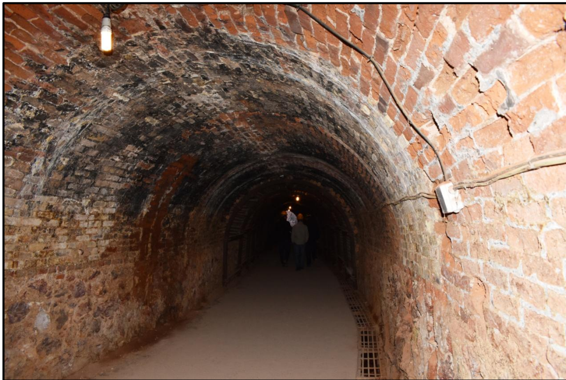
Entibación de mampostería en un tramo del túnel Werner.
