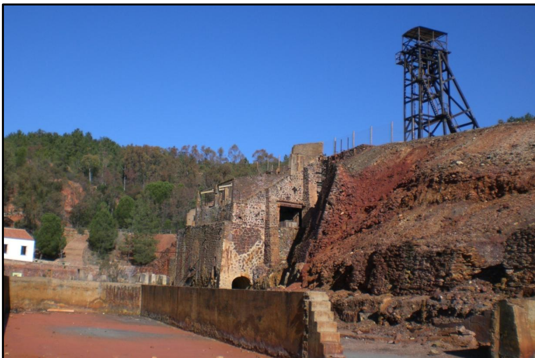
Vista lateral del castillete del Pozo Maestro con la trituración primaria debajo. El Centro de Interpretación Peña del Hierro es la edificación blanca de la izquierda.
