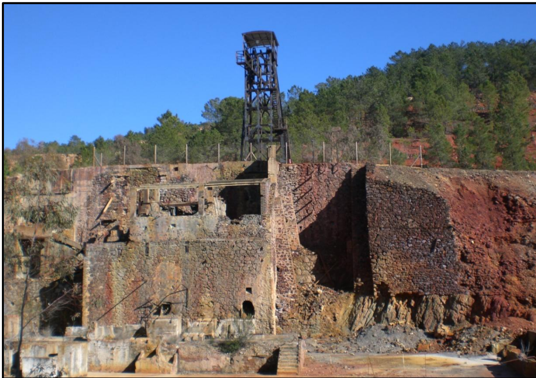
Vista frontal del castillete del Pozo Maestro con la trituración primaria debajo.
